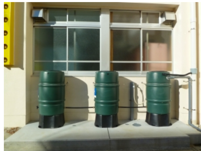
雨水貯留タンク
