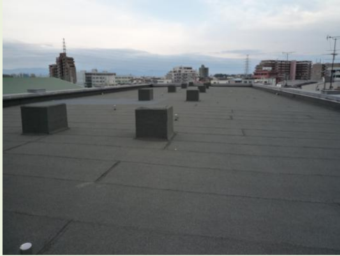
【10棟 屋上 改修前】
