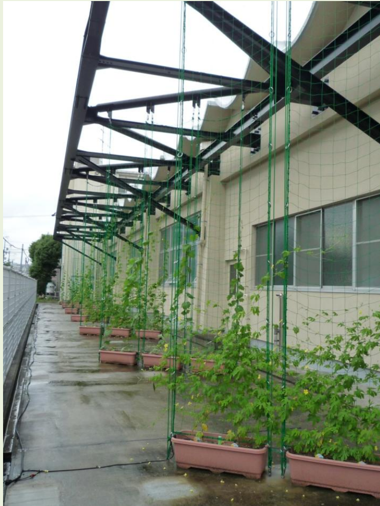
【 耐震フレームを利用したグリーンカーテン 】
