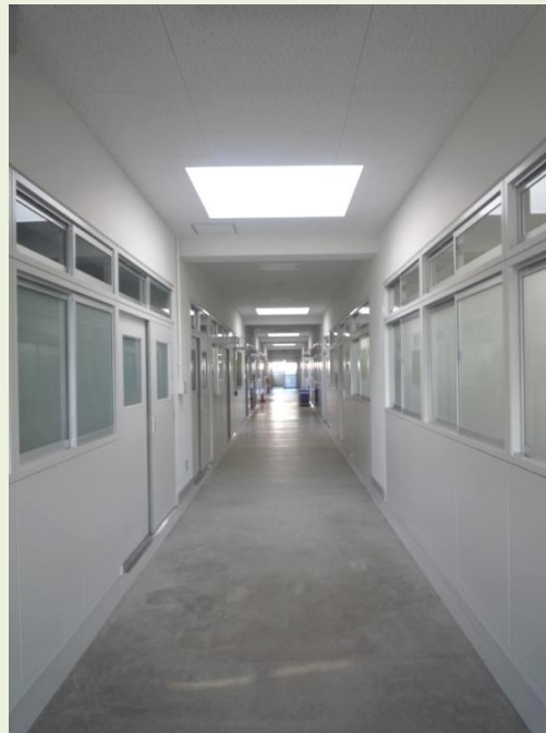
【 10棟 2階中廊下 改修後 】
