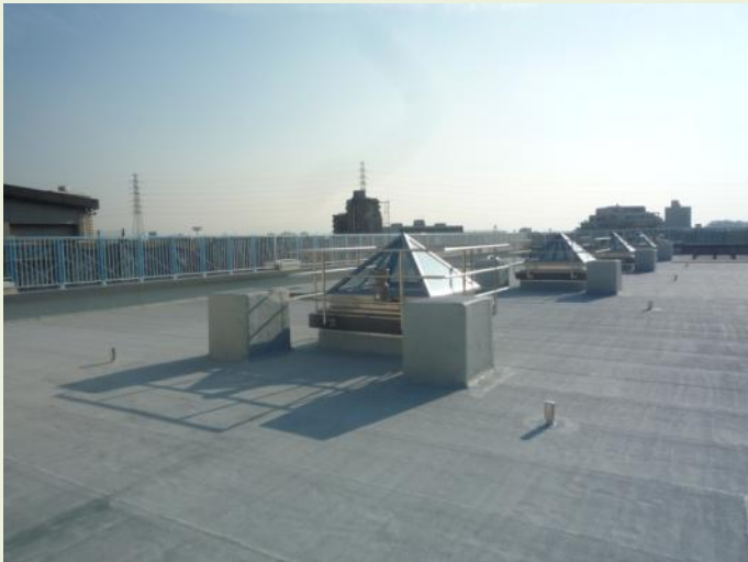
【10棟 屋上 改修後】
