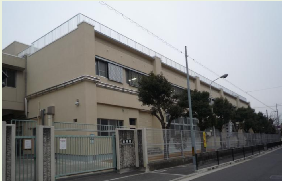
【 10棟外観 改修後 】
