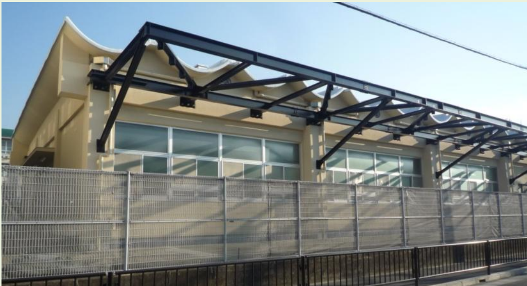
【 9棟外観 改修後 】
