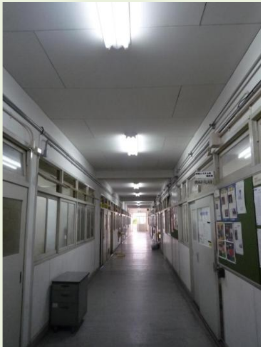
【 10棟 2階中廊下 改修前 】
