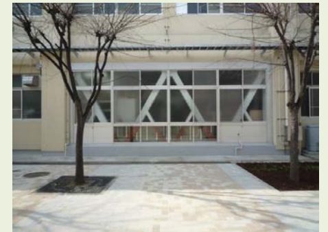
【10棟 耐震ブレース】
