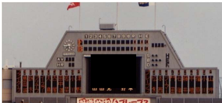
西宮球場（2005年解体）
