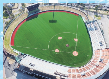
南港中央野球場グラウンド改修
