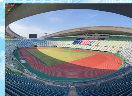
長居陸上競技場WAクラス2トラック・フィールド改修工事
