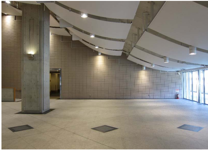
1階ホール 膜天井新設 天井高さ 2.3m～
