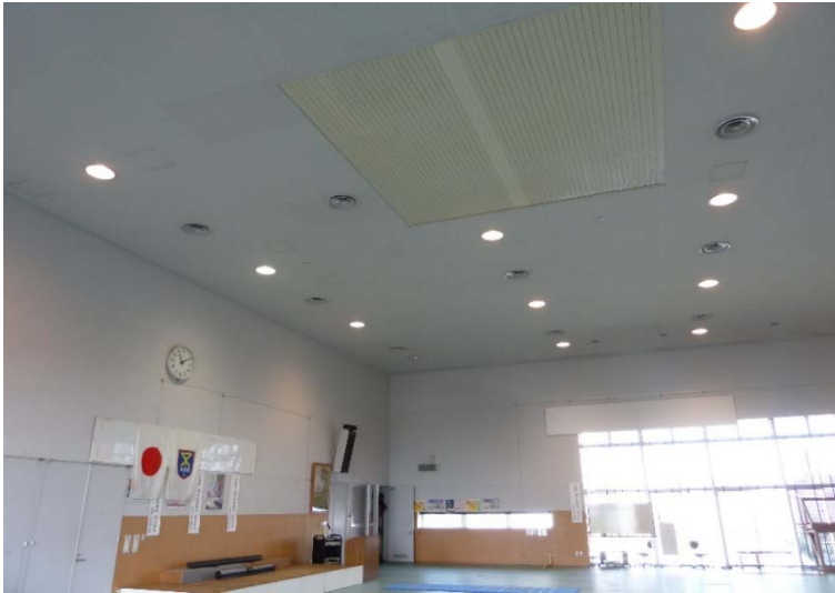
6階 講堂 天井高さ 6.35m 天井面積 353㎡
