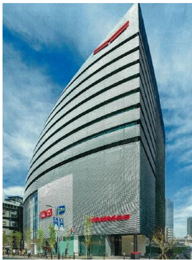
ヤンマー本社ビル
