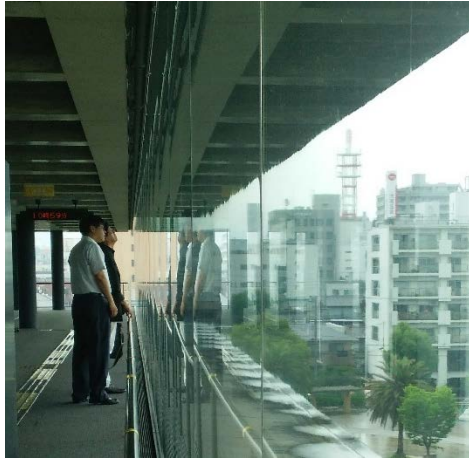
図 3-39 窓際自然換気口
