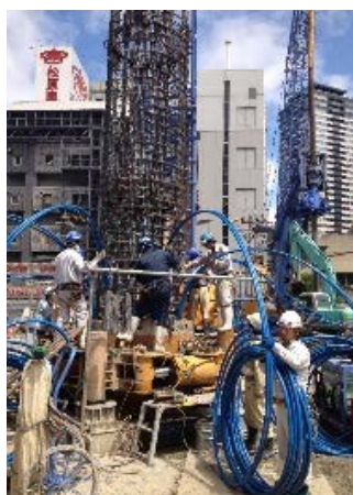
図 3-16 地中熱交換杭施工状況
